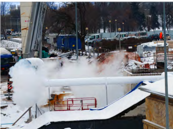
Ableitung von gasförmigen N2
